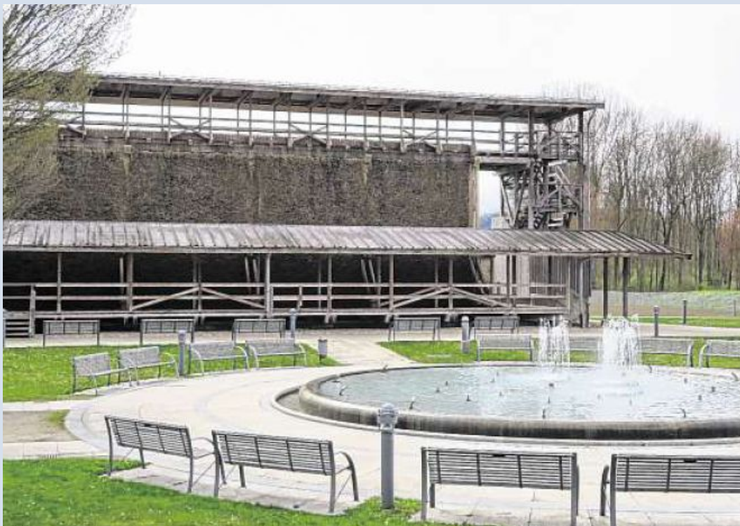
Wasserspiele: Seit 29. März sind die beiden Gradierwerke im Bad Staffelsteiner Kurpark wieder geöffnet.
